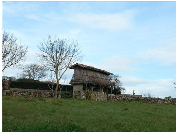
**Descripción:** Hórreo asociado a una vivienda tradicional. Soporte compuesto por cuatro cepas de granito con "tornarratos" apoyadas sobre la base de un muro de mampostería vista. La cámara está construida en madera, padieiras ensambladas, penal y pinche de listones de madera. Los costales cerrados con listones verticales de madera con faja horizontal. No tiene pináculos. La cubierta es de estructura de madera, formando voladizo sobre la cámara y está acabada en teja a dos aguas.
