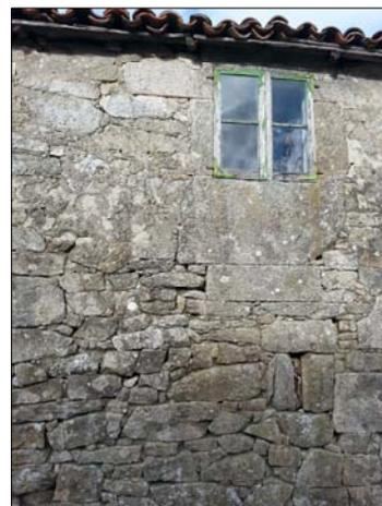
**Descripción:** Vivienda tradicional exenta de planta en forma de "L". Presenta muros de mampostería vistos. Los huecos de puertas y ventanas están adintelados con elementos de piedra de cantería. Las carpinterías de las ventanas son batientes de dos hojas de madera pintada en verde. La cubierta es a tres aguas con estructura de madera y acabado en teja.
