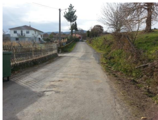
Foto 17 - Esmoriz. Carretera LU-P-1810. Cierres tradicionales
